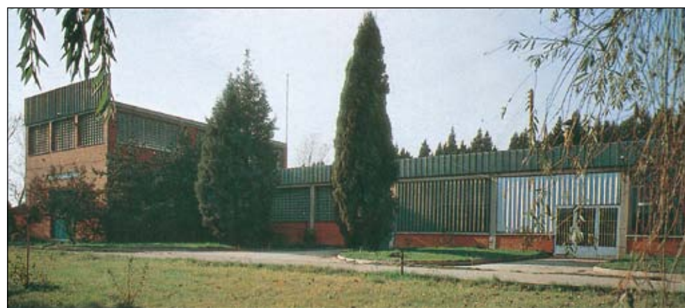
Planta de esterilización
